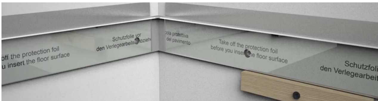
Montáž pred zhotovením poteru.
