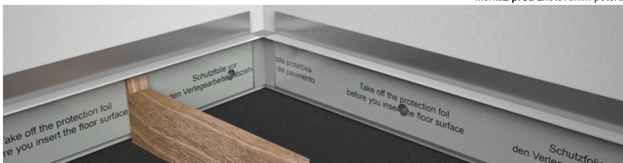
Montáž po zhotovení poteru.
