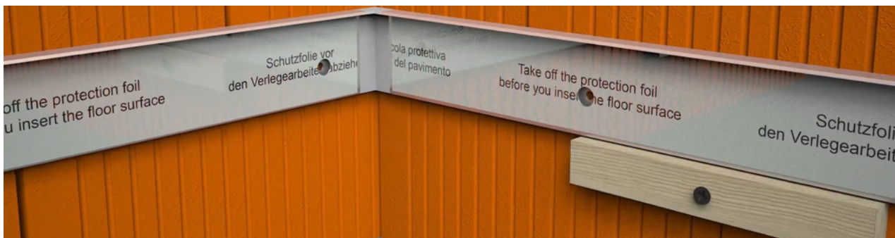
Montáž pred zhotovením poteru.
